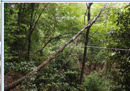
16 日 掛かり木除去作業中
