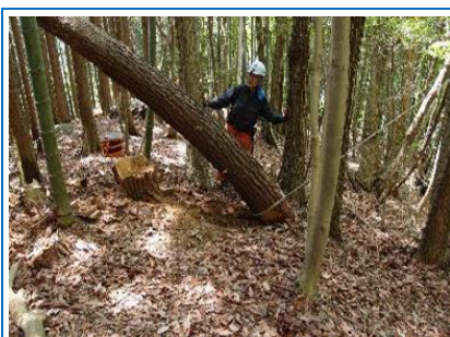
3 日 枯れ松の除去作業中
